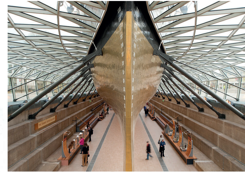
Referentie voor plaatsing de Hudson: Cutty Sark Conservation Project, Greenwich, VK.
